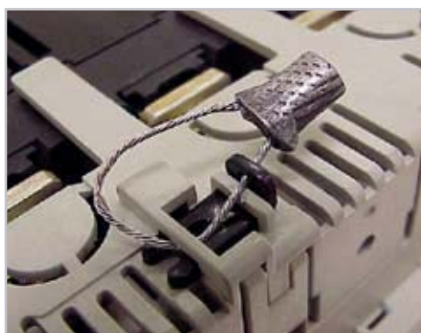
Блокировка клеммной крышки свинцовой пломбой
